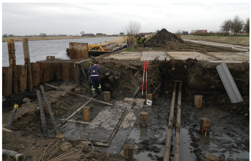
Afbeelding 5: inspectie van kadedoorlaat 3.
