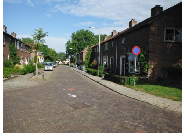
Vanuit oostelijke richting nabij boring 11
