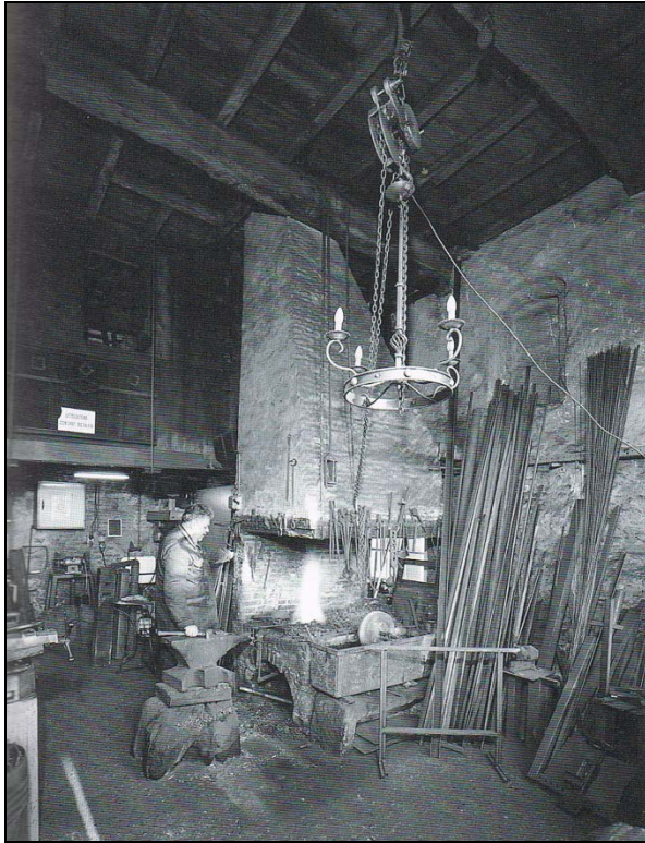
Afbeelding 30. Voorbeeld van een in oorsprong 17 de eeuwse smederij in Elburg. Centraal in de ruimte het smidsvuur onder een grote rookkap. Bron: Meischke, Zantkuijl & Rosenberg, 2000.
