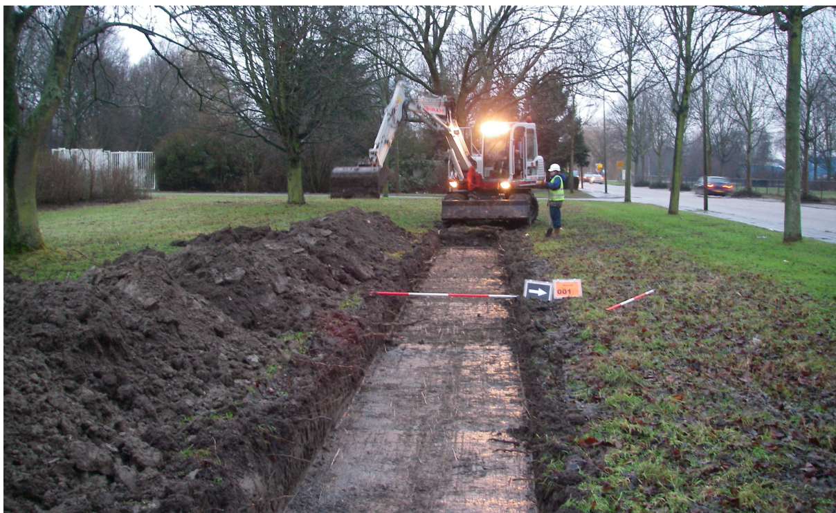
Afbeelding 9: sfeerfoto van de aanleg van de proefsleuf.
