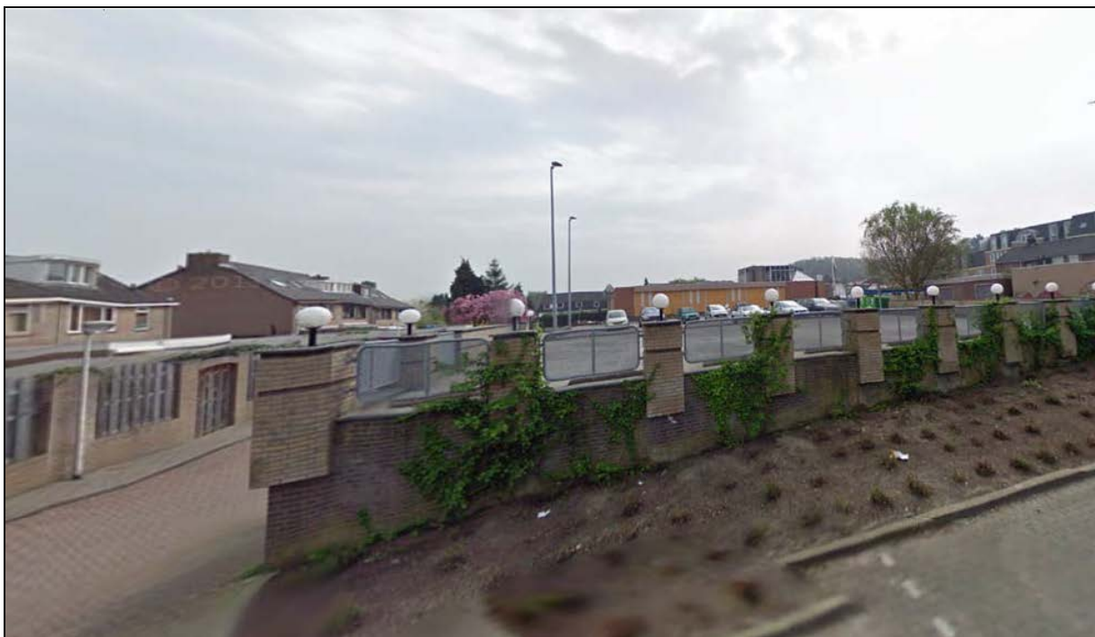
Afbeelding 20. De situatie ter plaatse van het noordwestelijke deel van het plangebied. Op deze foto is de verhoogde ligging van de supermarkt en het parkeerterrein ten opzichte van het straatniveau van de Akenshof duidelijk zichtbaar. Bron: Google.nl/ maps, 2014 (foto, 2009).
