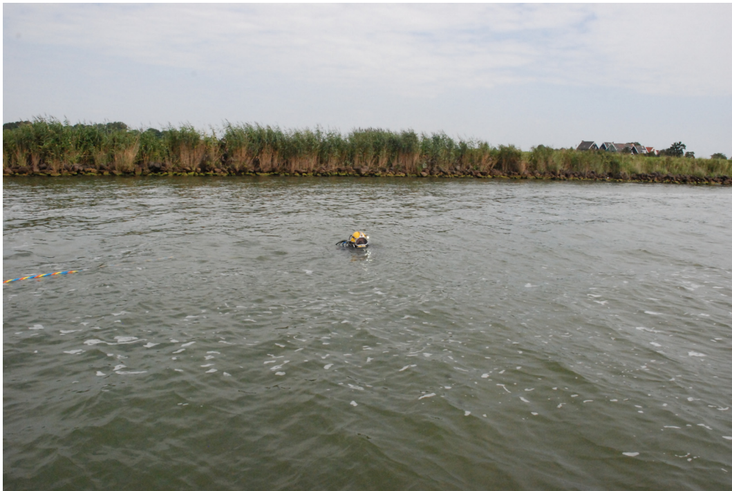
Afb. 5. Duikwerkzaamheden langs de dijk bij Marken.
