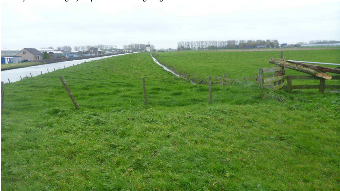
Afbeelding 2 Foto (richting zuid) van een deel van het plangebied: kadevak 5 langs de Monsterwatering, gezien vanaf de kulk met de Groeneveldse molen op de achtergrond.
