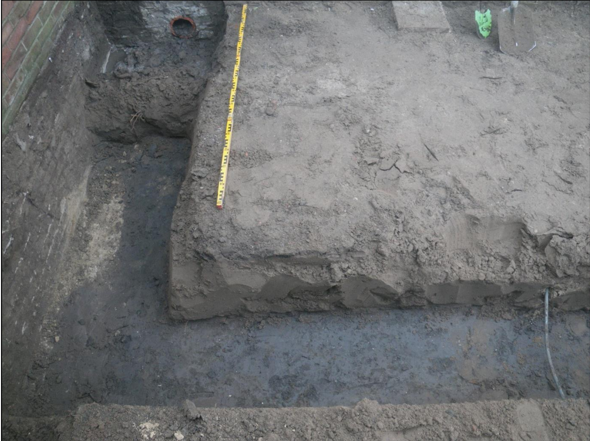
Figuur 3: Op de bodem van de funderings sleuf werd een oud loopniveau zichtbaar onder een dik pakket bouwzand. De foto is richting het zuiden gemaakt.
