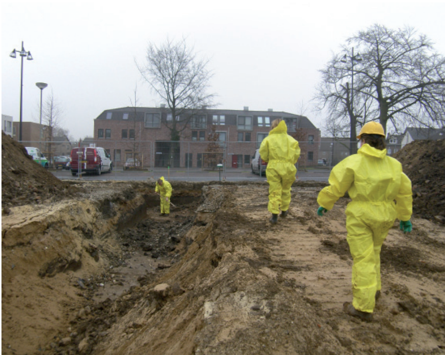
Afb. 2.2 Sleuf 3 na vier weken vorst met het veldteam in saneringsoveralls.
