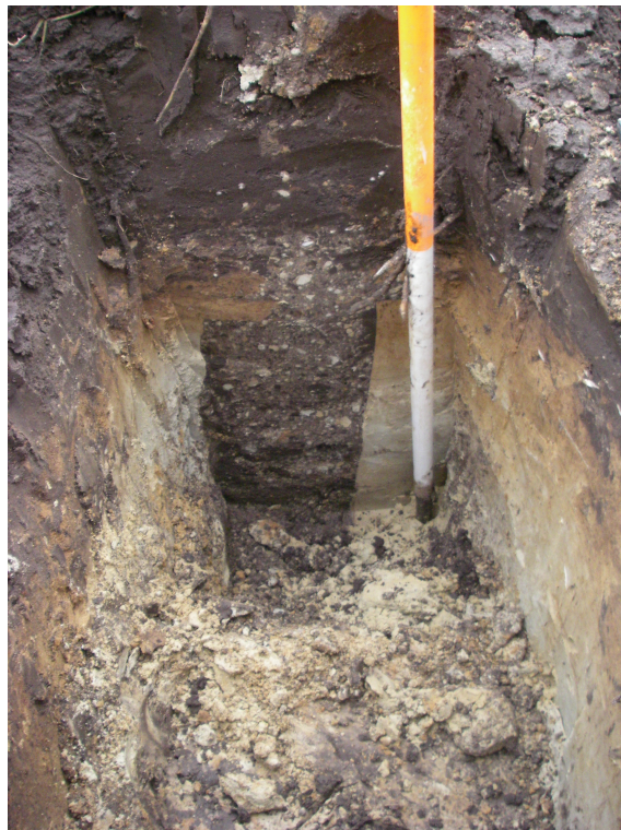
Afbeelding 4 Insteek drainage in profielkuil nabij boring 13.
