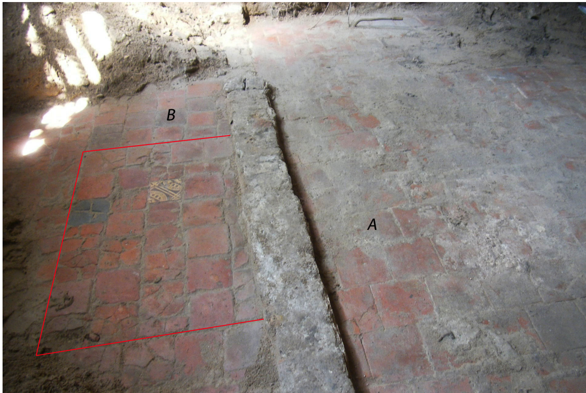
Afb. 19. De 17e -eeuwse plavuizenvloer in de ruimtes A en B met de scheidingsmuur S57. Links is het afwijkende blok tegels in ruimte B te zien (rood) met daarin de zwarte plavuis en de spreuktegel.
