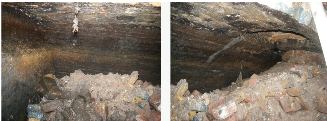
Afb. 23. De binnenkant van de beerkelder. Aan de verkleuring op de randen is te zien dat de beerkelder tot een hoger niveau gevuld is geweest. Rechts zijn twee stortpijpen zichtbaar.
