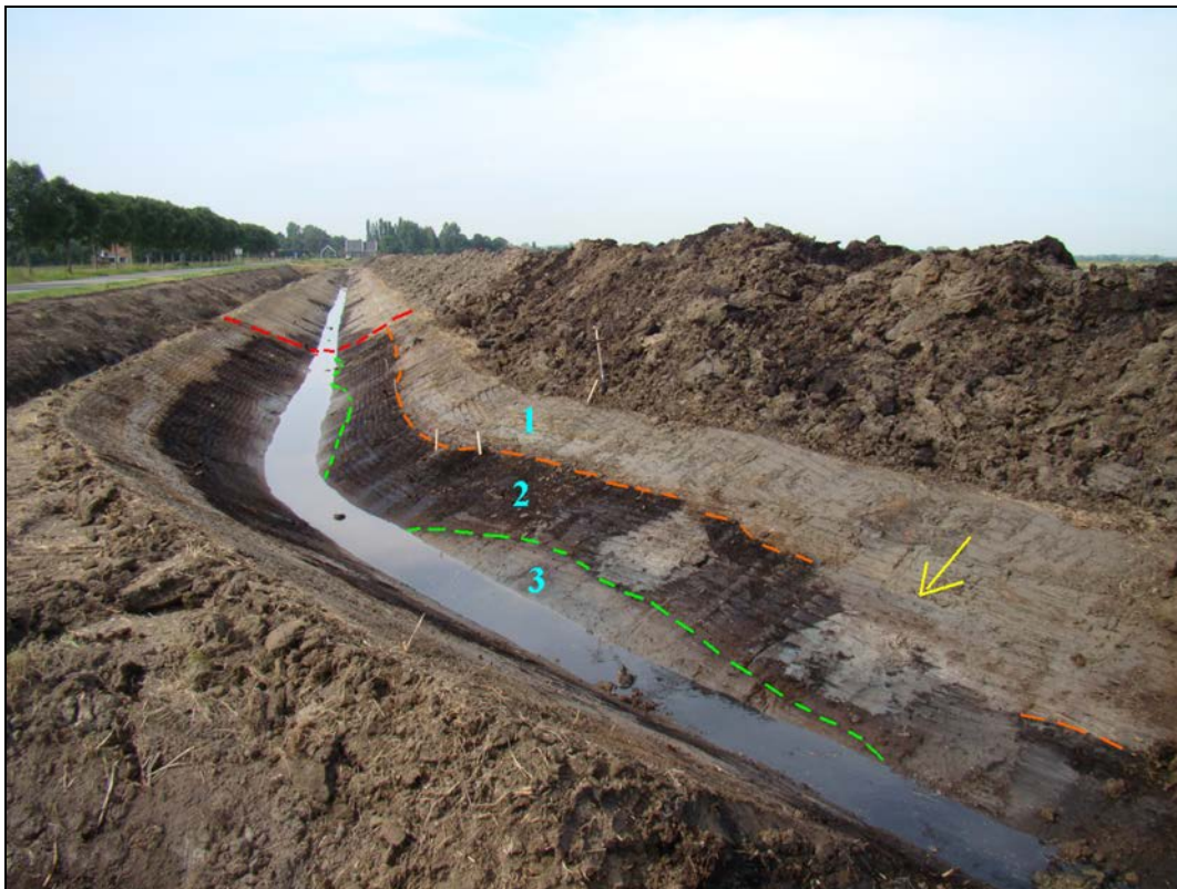
Afbeelding 7. De bodemopbouw ter plaatse van het onder archeologische begeleiding ten zuidwesten van de kruising Kloetingseweg - Noordhoekweg gegraven deel van de nieuwe sloot. De begrenzing van de zone die onder begeleiding is aangelegd, is met een onderbroken, rode lijn gemarkeerd. De begrenzing van de Afzettingen van Calais (lichtblauwe 3) is met een lichtgroene onderbroken lijn gemarkeerd. De begrenzing van de top van het Hollandveen (lichtblauwe 2) is met een onderbroken, oranje lijn gemarkeerd. Daarboven tot aan het maaiveld Afzettingen van Duinkerke II (lichtblauwe 1). Sporen van moertering zijn met een gele pijl gemarkeerd. Foto genomen naar het zuidwesten. Let op: de foto (Fotonummer 3) is genomen van een schuin talud!
