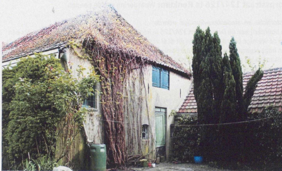
Afb. 8 Hoek van de rechter zijgevel van het bedrijfsgedeelte. Tegen de achtergevel is een kleine wagenschuur aangebouwd (foto BAAC).
