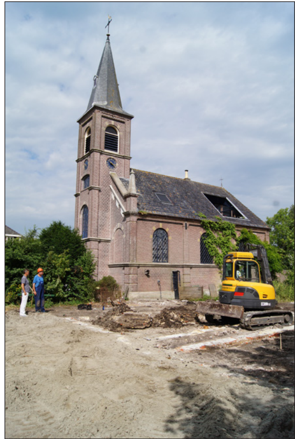
Afbeelding 14. Het plangebied Scharwoude 7 tijdens de begeleiding van de sloop van de funderingen van de voormalige pastorie.
