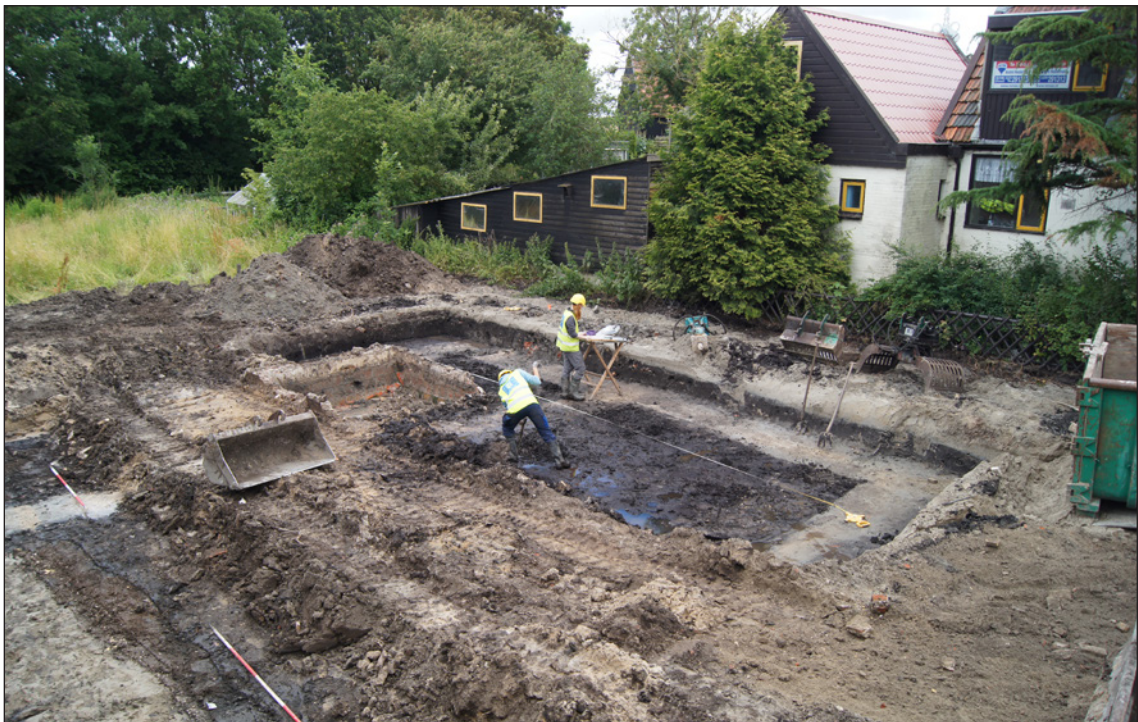
Afbeelding 15. De werkput met het achtererf van Scharwoude 7. In de werkput bleef even een rijbaan staan voor de kraan, om de kelder zo laat mogelijk te kunnen slopen.
