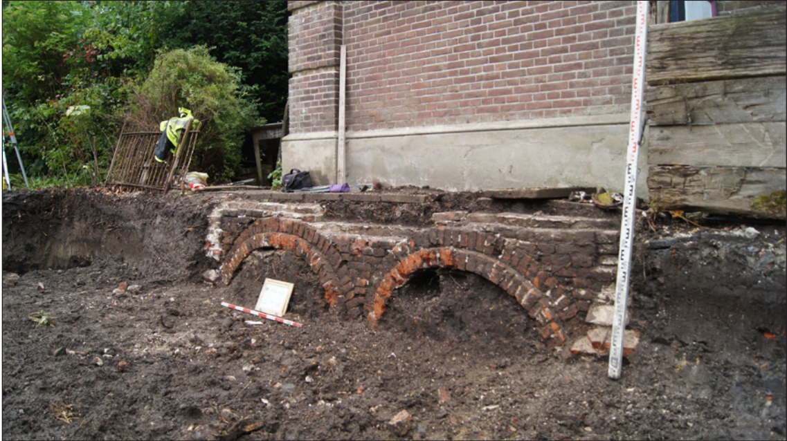
Afbeelding 27. Een deel van de spaarboogfundering (S41) was al te zien in het westprofiel van de werkput.
