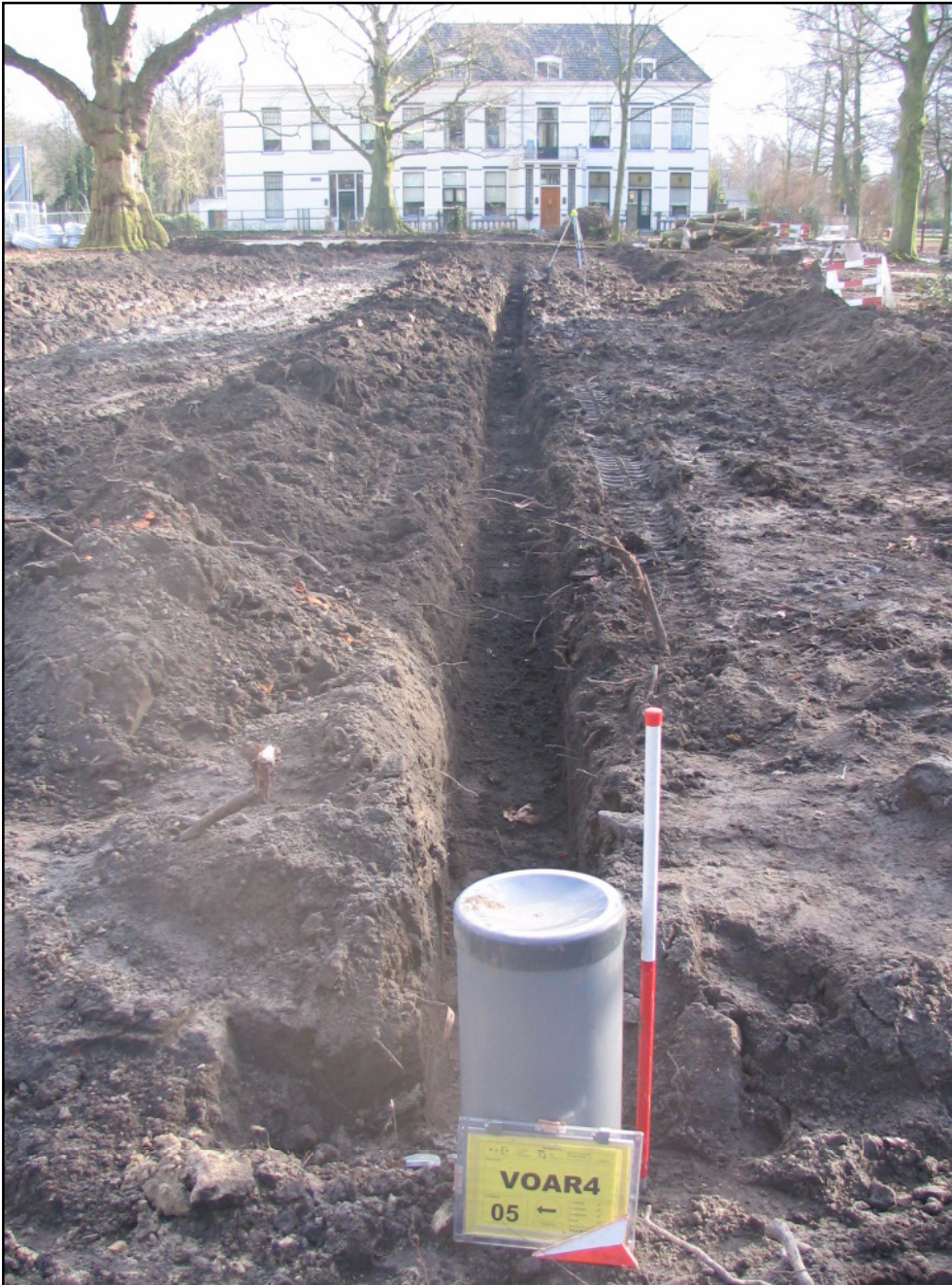
Figuur 3. Overzicht drainagesleuf 4 richting het zuidoosten, met op de achtergrond Villa Hoekenburg.
