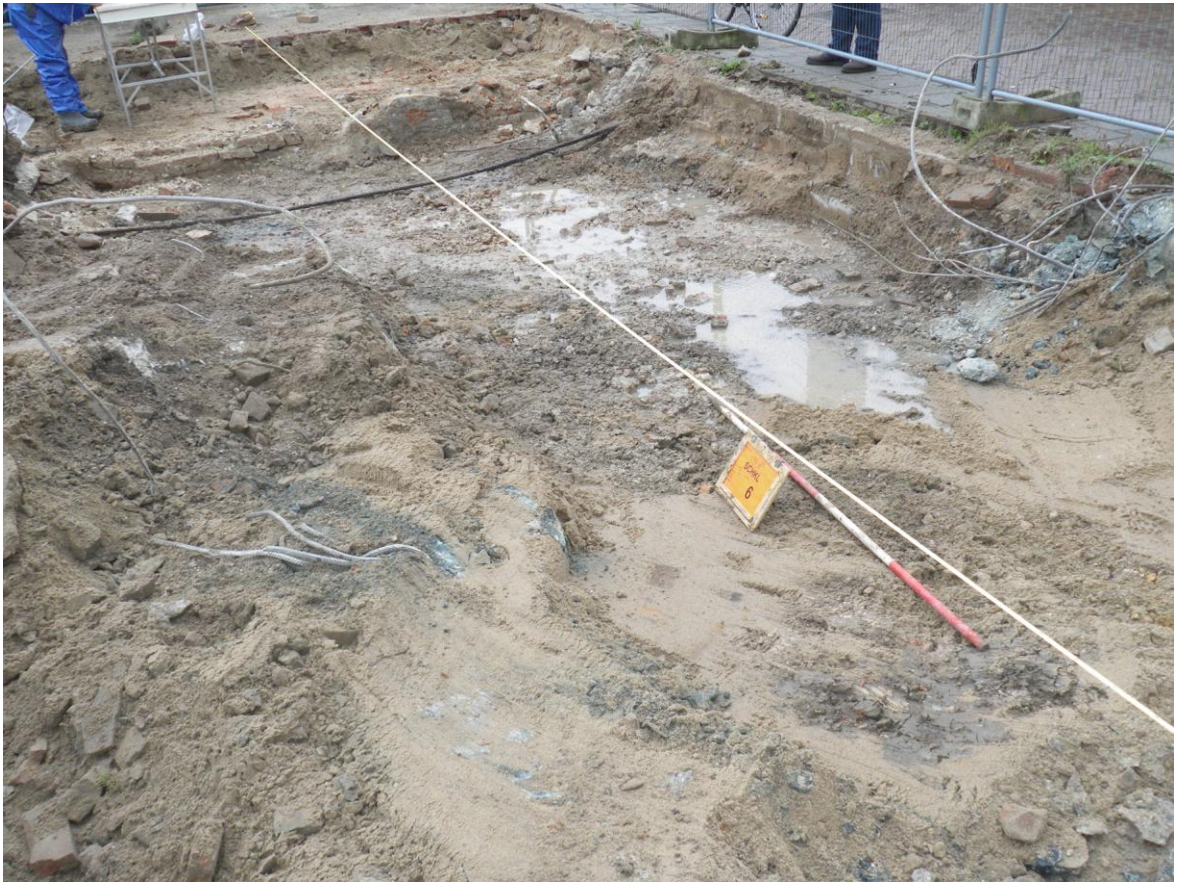
Afbeelding 3.5: Werkput 3, vlak 1 noordwaarts gefotografeerd met op de voorgrond de insteek van de fabriekskelder, in het midden het afbraakpuin uit de periode 1650 -1830 (spoor 26) en daarachter het hoger aangelegde deel met muur 21 en vloerresten. Rechtsboven is de rijbaan van de Molenstraat in beeld.
