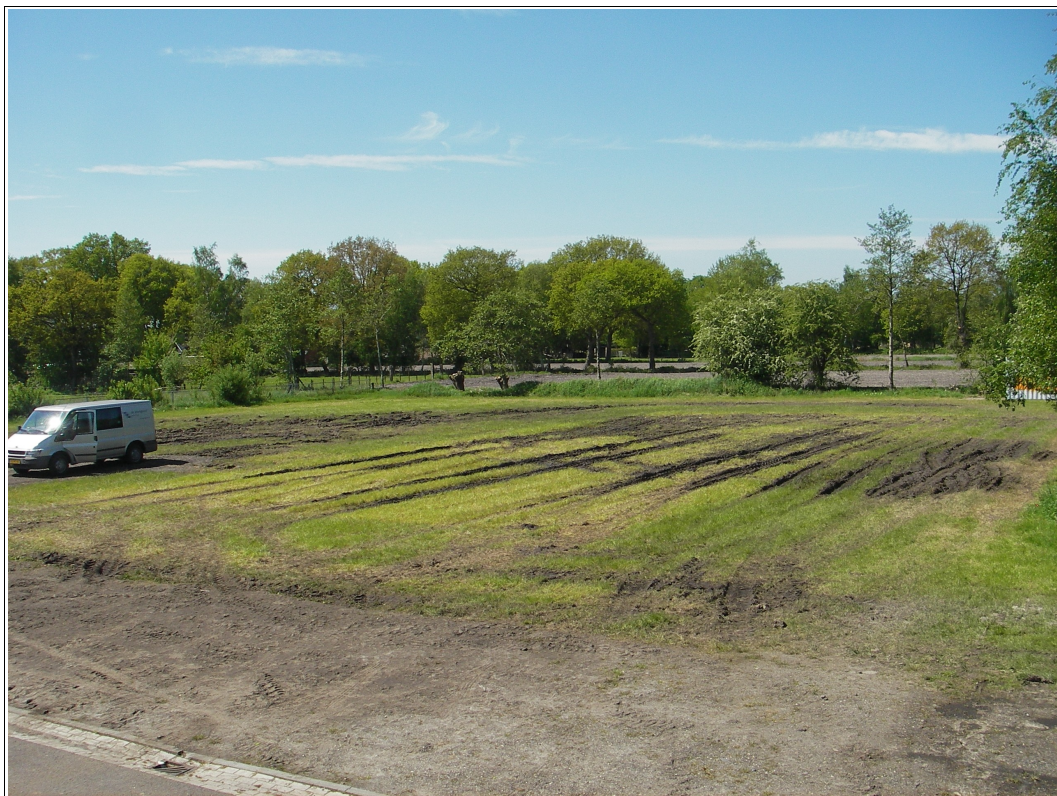
Figuur 2: Opende, Verbindingsweg: Foto genomen in zuidwestelijke richting.
