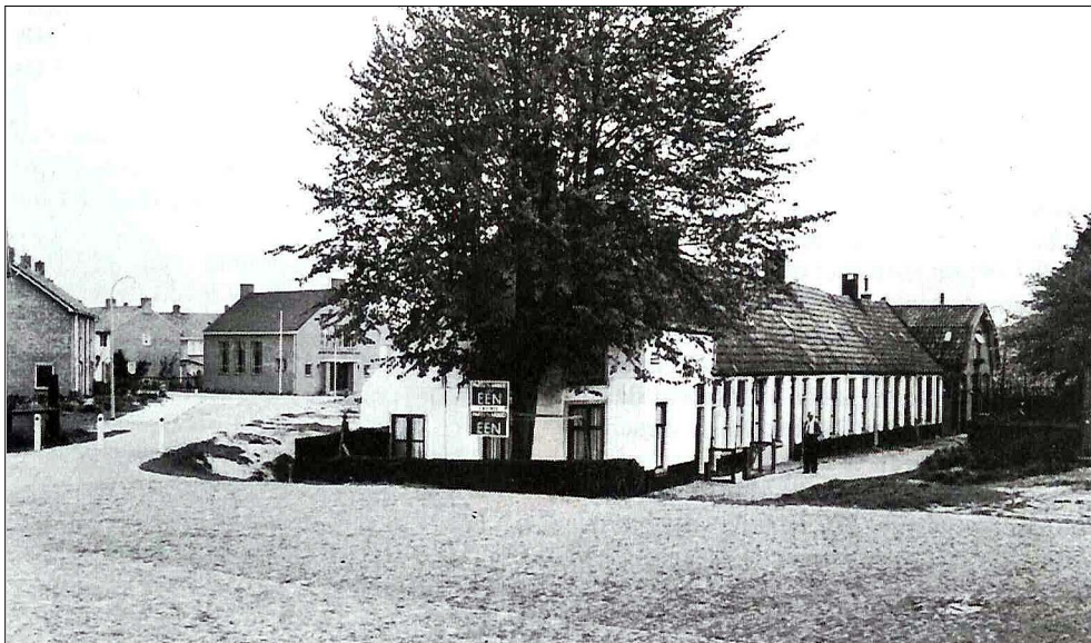
Figuur 18. Situatie rond 1960. Gebouw 'De Locomotief' aan de Paardenmarkt.
