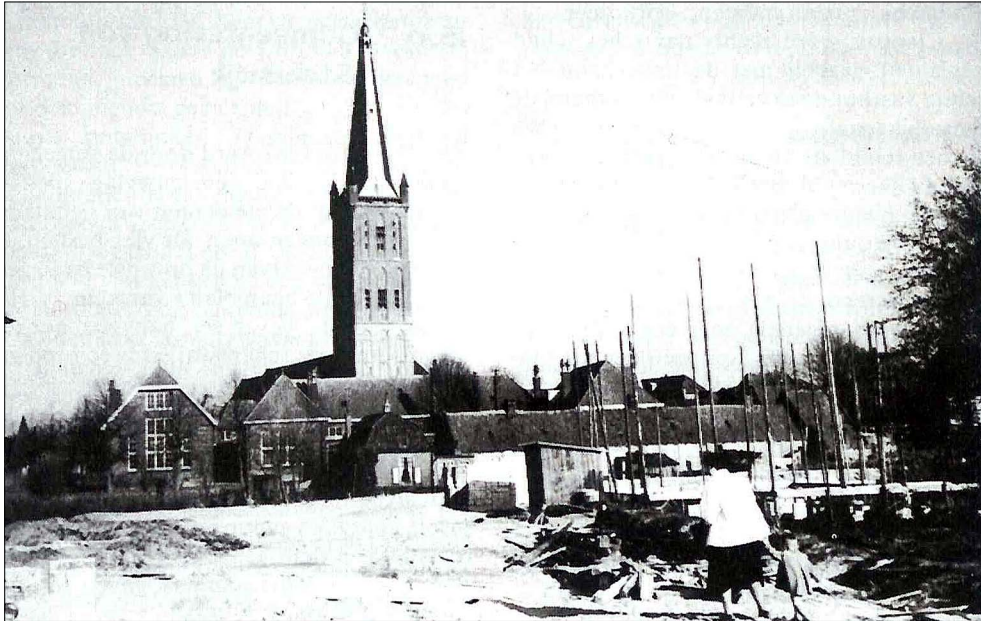
Figuur 17. Situatie rond 1940. Begin van de woningbouw op de Torenlanden.
