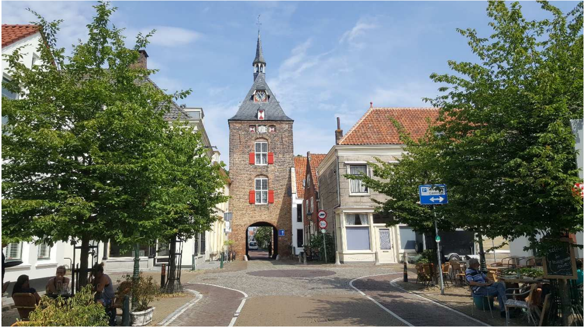
Afbeelding 14 Impressie plangebied met de Lekpoort (foto richting het noorden). Bron: Foto Vestigia d.d. 1 juni 2018.
