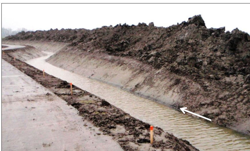
Afbeelding 6. Beel van locatie 2 in zuidelijke richting. Bij de pijl is de veenondergrond te zien. Rechts op de foto een voor de aanleg van de sloot gedempte dwarssloot
