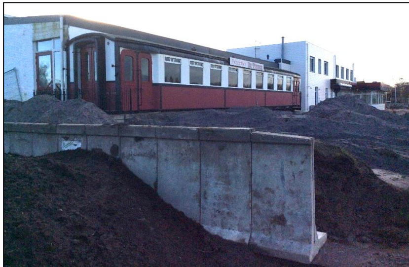
Figuur 5: beeld van de werkzaamheden aan het verhoogde terras in het noorden van het plangebied. Boringen 1 en 2 zijn hier omheen gezet.
