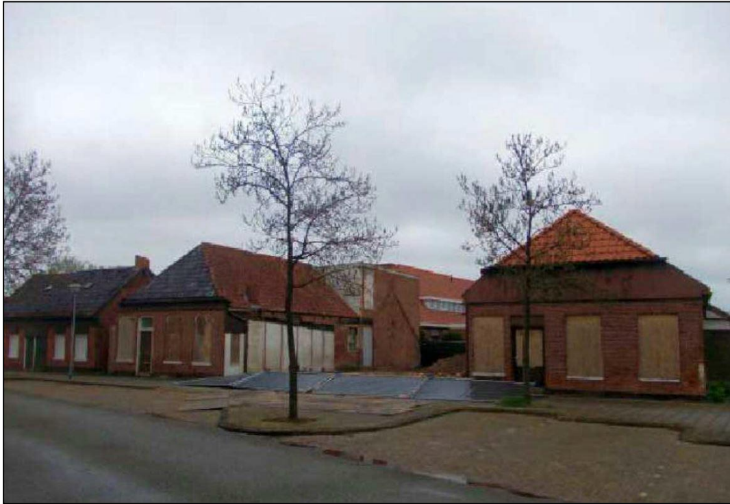
Figuur 11: Foto van het plangebied voor de sloop (de bebouwing links in de foto: 2016).
