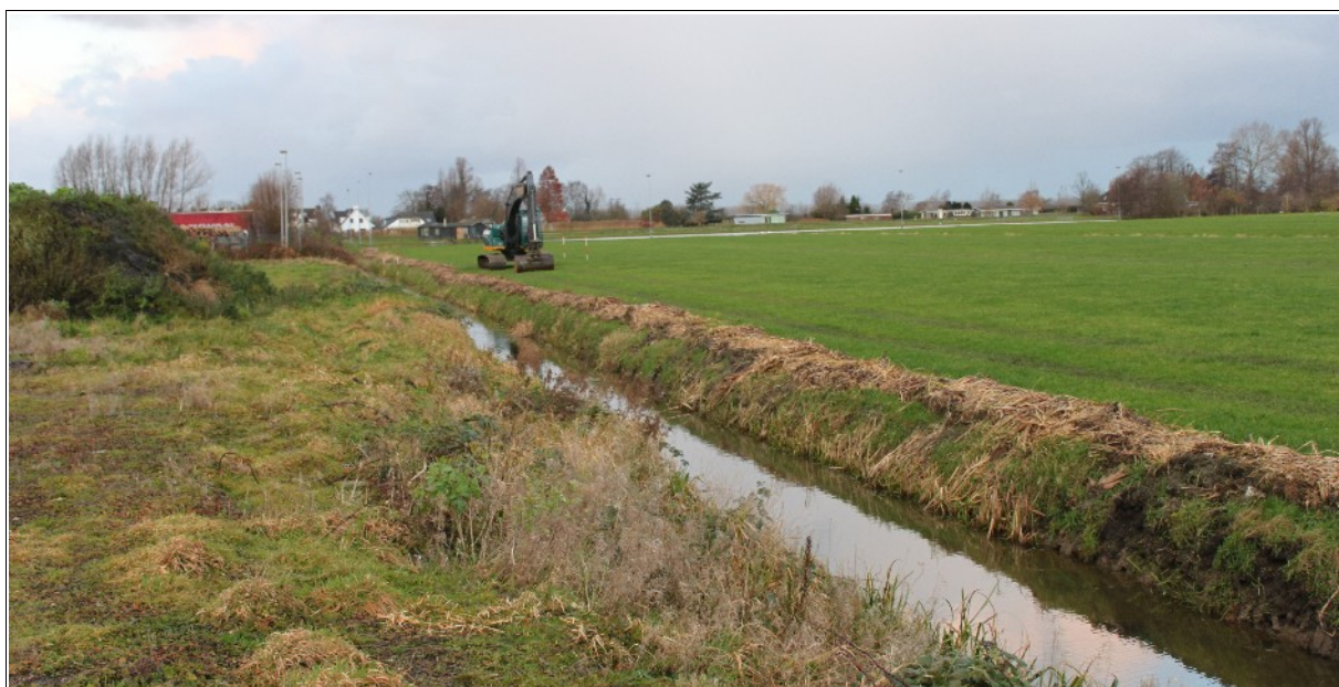
Figuur 2. Het plangebied (rechts van de sloot) voor aanvang van de werkzaamheden.
