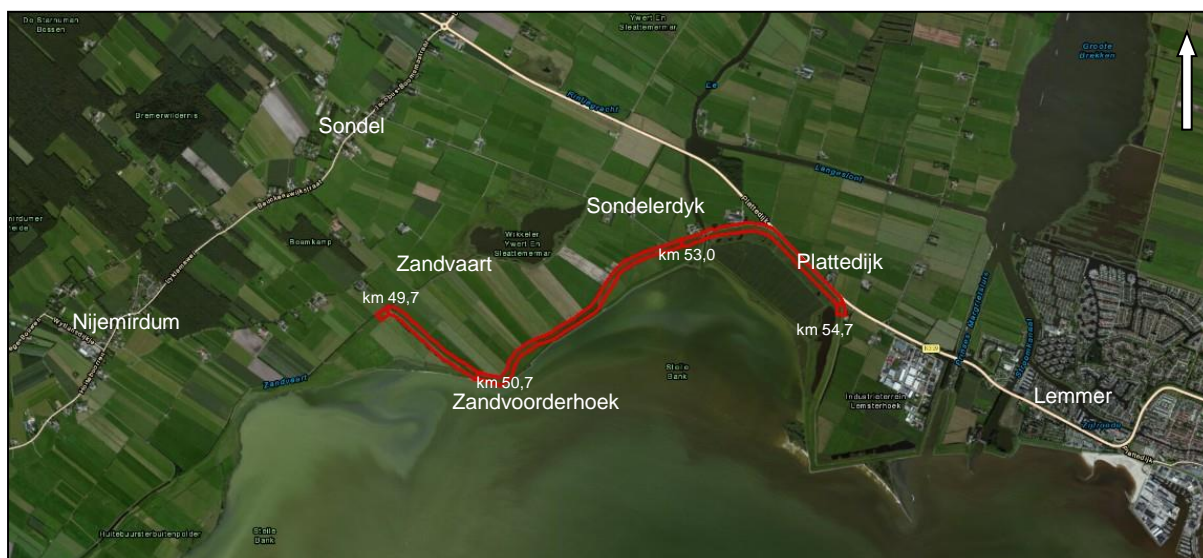
Figuur 1 Het plangebied (rood omlijnd) op een luchtfoto uit ongeveer 2012 (bron: Bing Maps).
