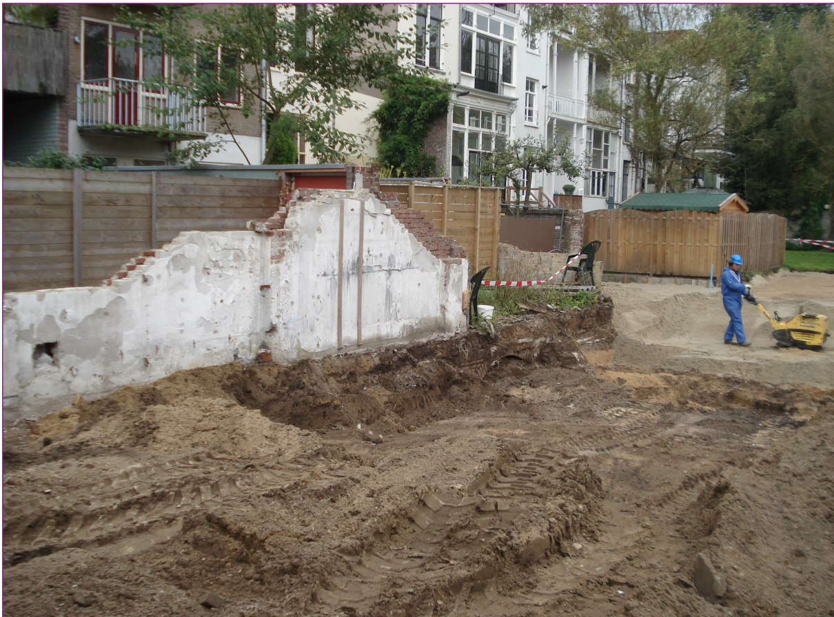
Afbeelding 14. Schoon zand wordt op het achtererf aangetrild. Op de voorgrond is de bruine opgebrachte grond zichtbaar die door de sloopwerkzaamheden is omgewoeld. De afbeelding is gezien vanuit het zuidoosten.
