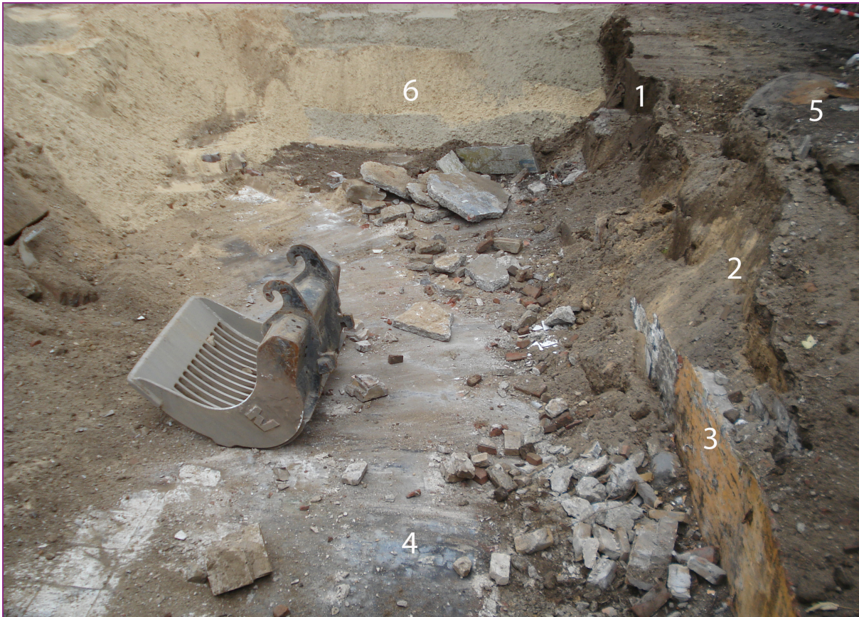
Afbeelding 15. De opgebrachte donkere grond van de bouwvoor (nummer 1) en resten geel zand uit de funderingssleuf van het naoorlogse pand (nummer 2). Op de voorgrond de muur (nummer 3) en vloer (nummer 4) van het voormalige pand. Rechtsachter de recente olietank (nummer 5). Midden-achter: het schone gele zand dat wordt aangevuld op de saneringslocatie op het achtererf (nummer 6). De afbeelding is gezien vanuit het zuidoosten.
