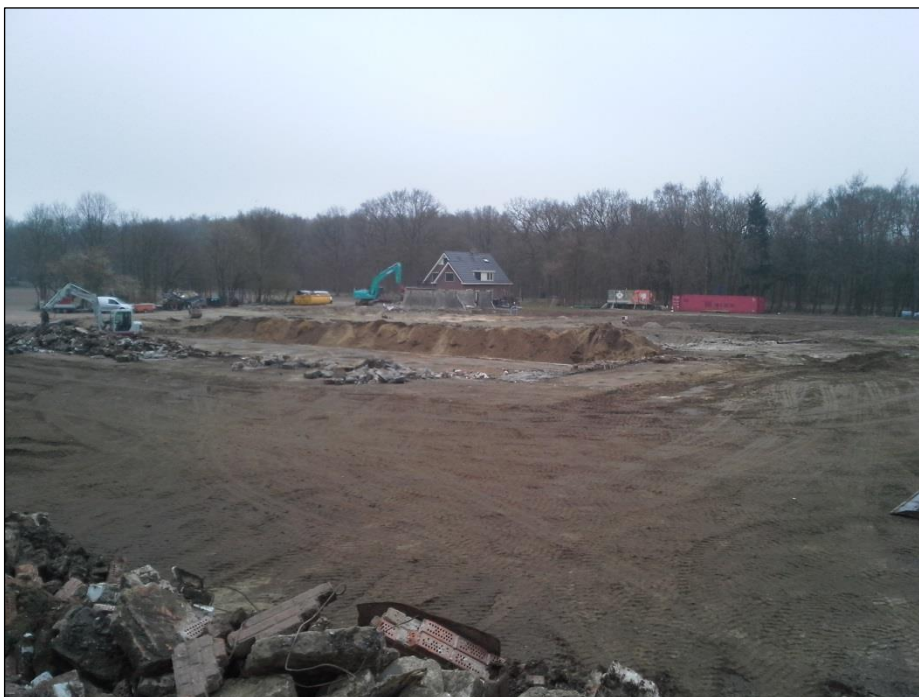
Figuur 3.1 Zicht op het plangebied vanuit de zuidoostelijke hoek van het plangebied. De slopwerkzaamheden zijn in volle gang.
