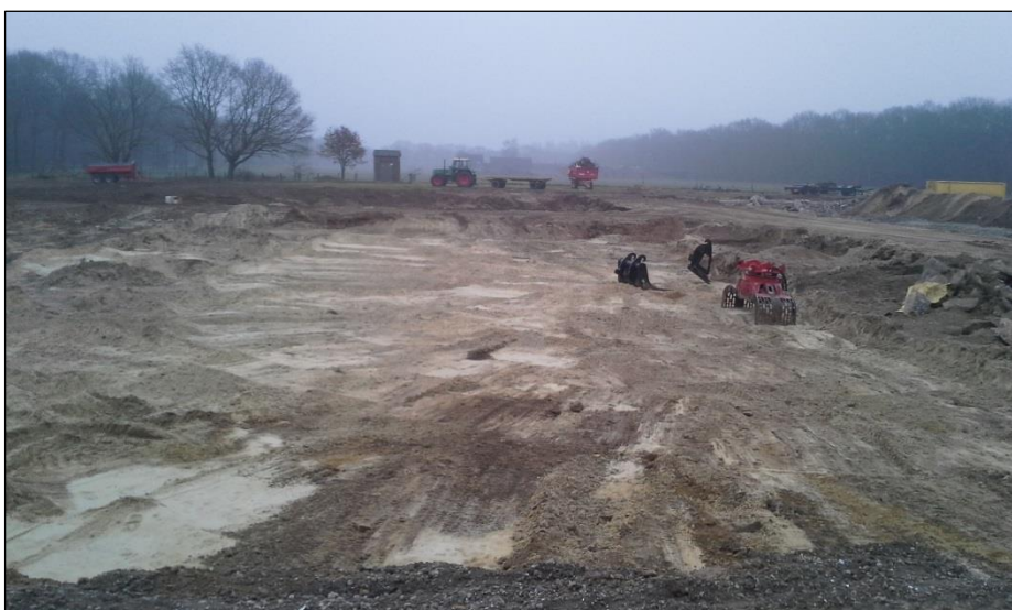
Figuur 3.2 Ontgravingsput van een van de gesloopte stallen.
