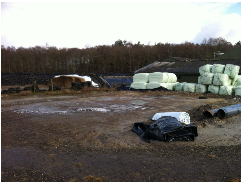
Figuur 3: Zuidvelde, De Fledders 6. Foto van het oostelijke deel van het plangebied, genomen richting het noordoosten. Dit gedeelte is in het verleden reeds ingericht en vergraven.
