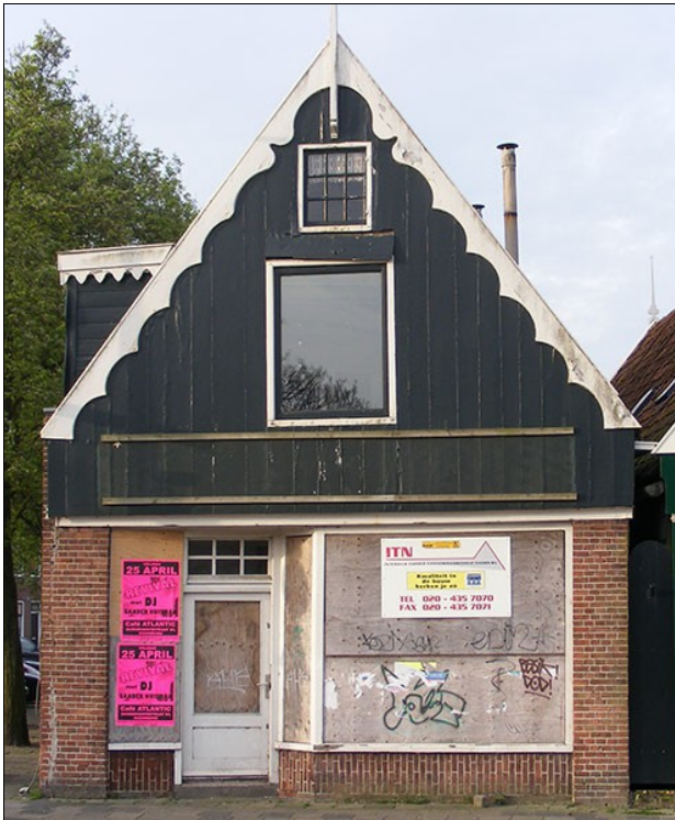
Afbeelding 4. De tot voor kort aanwezige bebouwing; een houten woonwinkelhuis met stenen voor- en zijgevel. Foto richting zuiden. Bron: Historische Vereniging Wormerveer.
