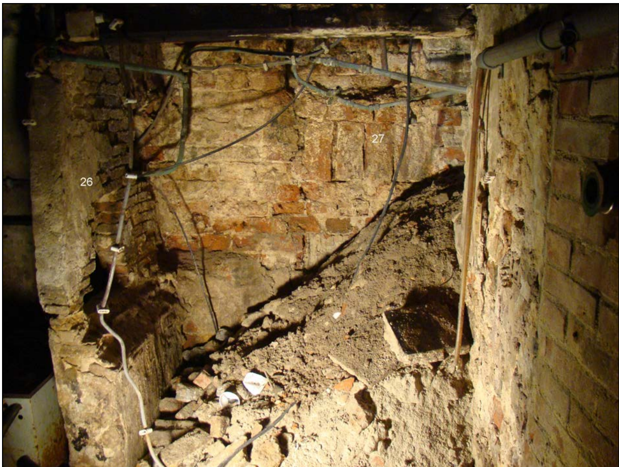
Afbeelding 41. De binnenkant van de bestaande kelder richting het zuidwesten gezien. Links het scheidingsmuurtje Spoor nr. 26 en in de kelderwand is de dichtgemetselde opening, Spoor nr. 27, zichtbaar.
