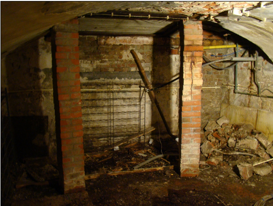
Afbeelding 40. De binnenkant van de bestaande kelder. Foto genomen vanuit noordwestelijke richting.
