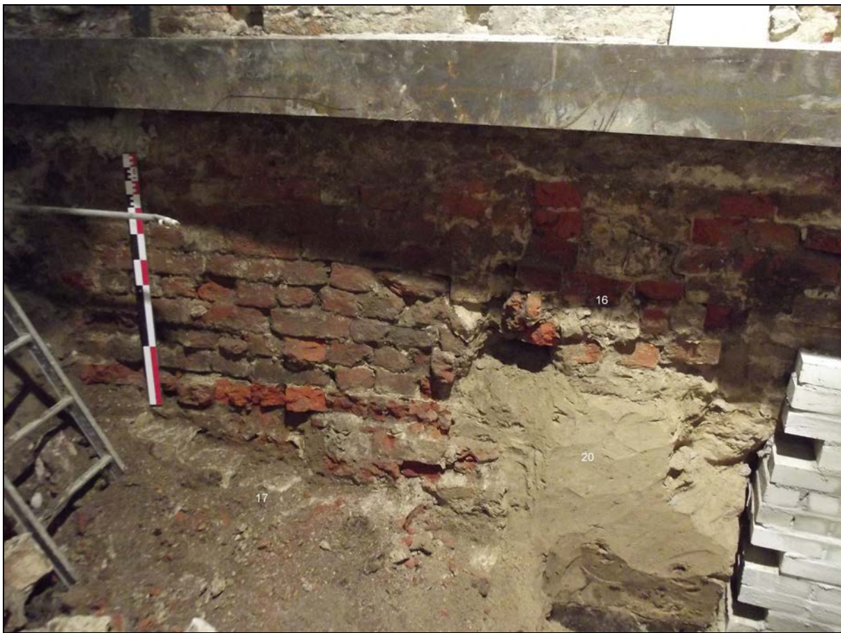
Afbeelding 34. Foto genomen na het gedeeltelijk slopen van de westelijke keldermuur. Hierachter kwam de fundering van de zijgevel tevoorschijn met een bijgekapte vlijlaag en daaronder vermoedelijk een puinlaag. Rechts ernaast de poer, Spoor nr. 16, op een grondverbetering (Spoor nr. 20).
