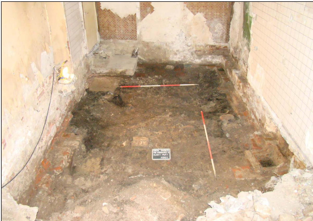
Afbeelding 30. Overzicht van het onderzoekgebied met het eerste vlak (Vlak 1), aangelegd op het niveau van de onderzijde van de fundering van de gevelmuren.
