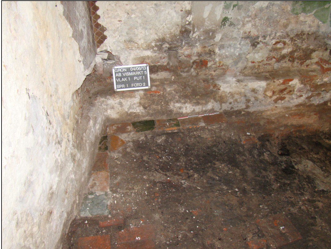
Afbeelding 31. Resten van de plavuizenvloer (Spoor nr. 1) in de noordoostelijke hoek van het pand. Deze zijn aangebracht op de bovenste van de twee funderingslagen.
