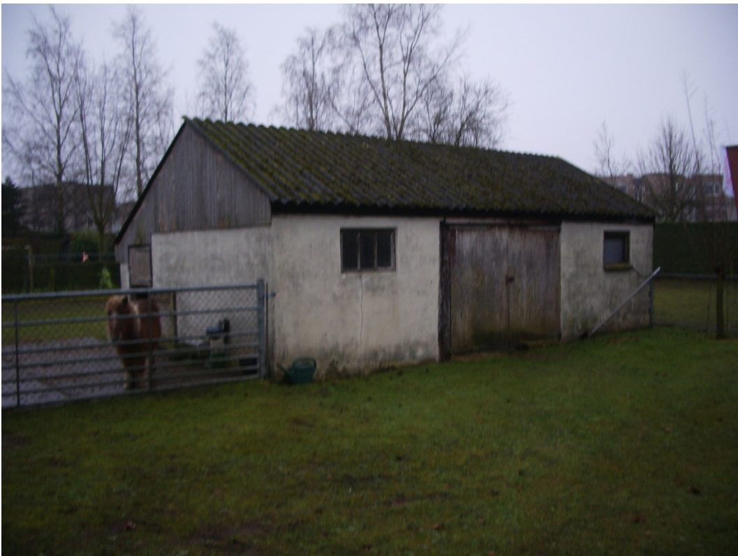
Afb. 12 Foto voorzijde zuidoostelijke schuur binnen het plangebied op 9 januari 2017.
