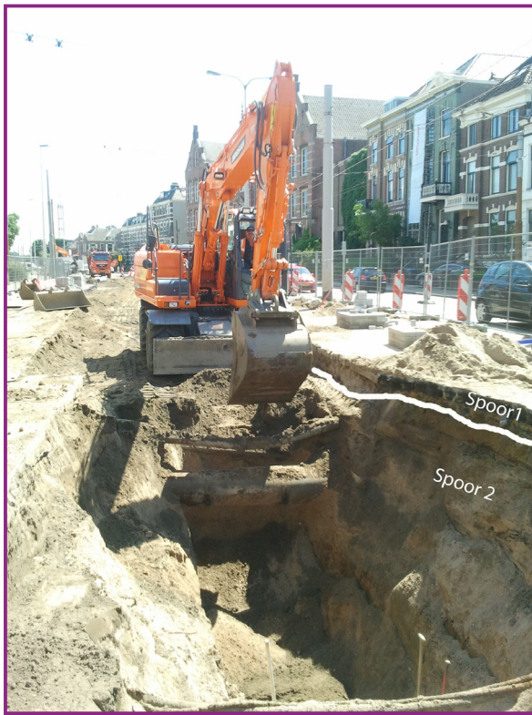
Afbeelding 31. Ontgraving ter plaatse van de Boulevard Heuvelink gezien vanuit het noordwesten. Spoor 1: de recent opgebrachte egalisatielaag met ingraving ten behoeve van het voormalig riool. Spoor 2: zandpakket ten behoeve van de ophoging van het Broek.
