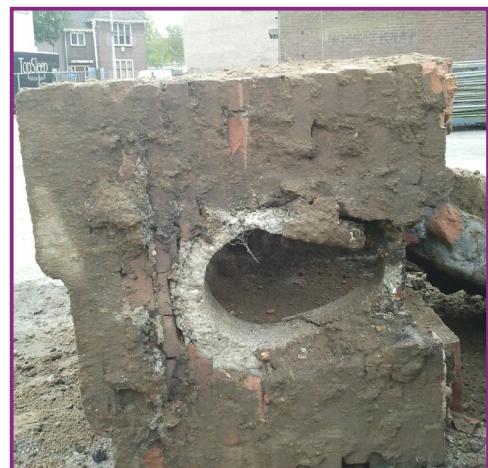
Afbeelding 39 en 40. Brokstukken van het gesloopte en vervangen 20 e -eeuwse voormalige riool uit de Rietgrachtstraat.
