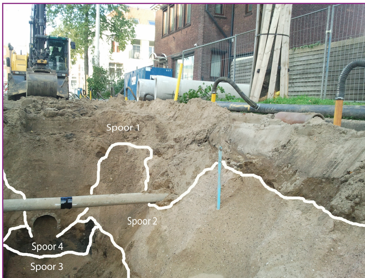
Afbeelding 30. Ontgraving in de Rietgrachtstraat gezien vanuit het zuidwesten. Spoor 1: de recent opgebrachte egalisatielaag met ingraving ten behoeve van het voormalig riool. Spoor 2: zandpakket ten behoeve van de ophoging van het Broek. Spoor 3: natuurlijke, kleiige ondergrond. Spoor 4: zuidelijke begrenzing van de dempingslaag van de Rietebeek of Rietgracht.
