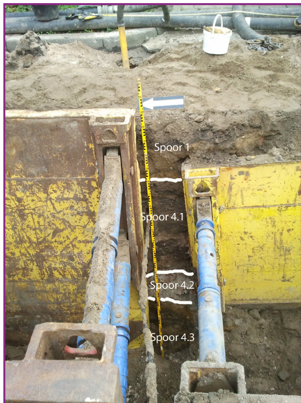
Afbeelding 35. Oostprofiel van de werkput in de Rietgrachtstraat tussen de metalen kisten. spoor 4: vullingen van de dempingslaag van de Rietebek of Rietgracht.
