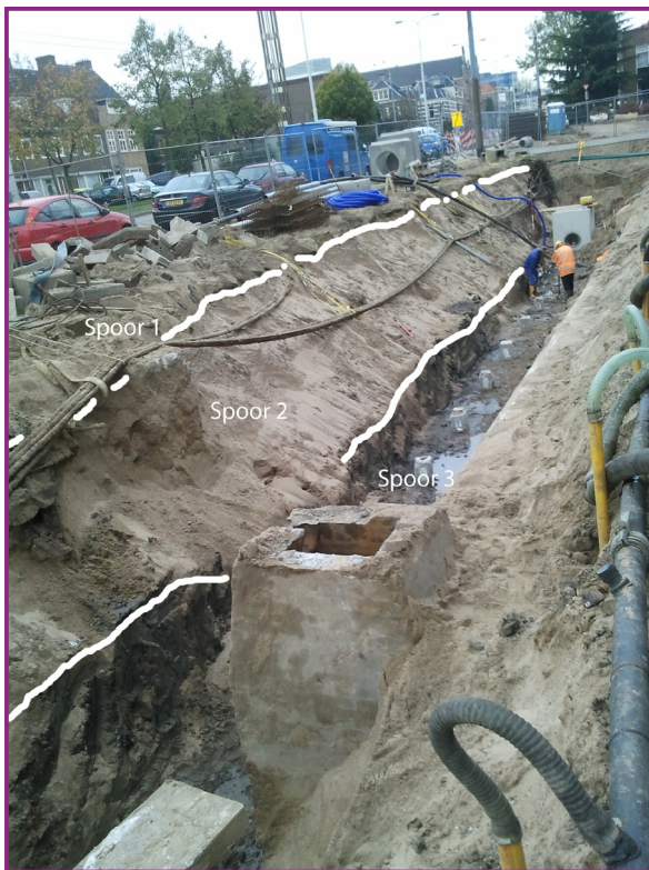
Afbeelding 32. Ontgraving in de Johan de Wittlaan gezien vanuit het noordoosten. Spoor 1: de recent opgebrachte egalisatielaag met ingraving ten behoeve van het voormalig riool. Spoor 2: zandpakket ten behoeve van de ophoging van het Broek. Spoor 3: natuurlijke, kleiige ondergrond.
