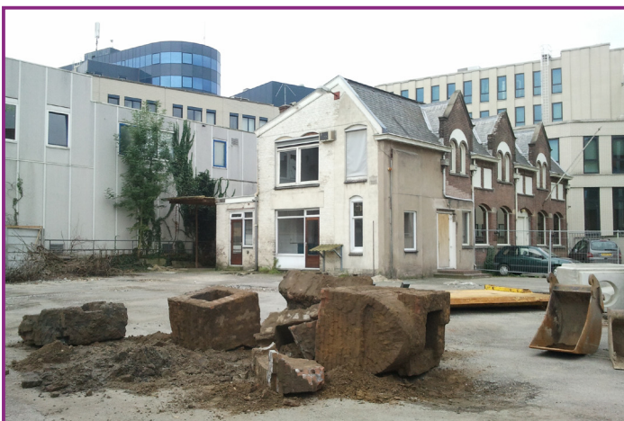
Afbeelding 39 en 40. Brokstukken van het gesloopte en vervangen 20 e -eeuwse voormalige riool uit de Rietgrachtstraat.
