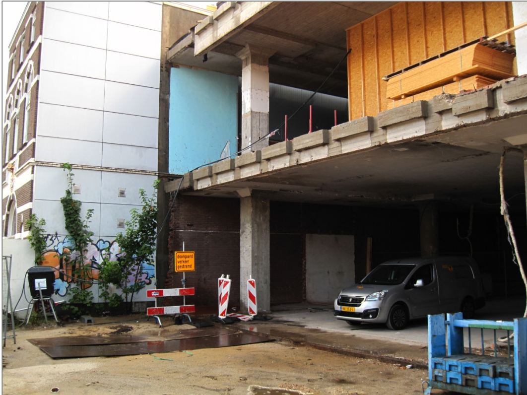
Afb. 12 Foto van het plangebied genomen in oostelijke richting.
