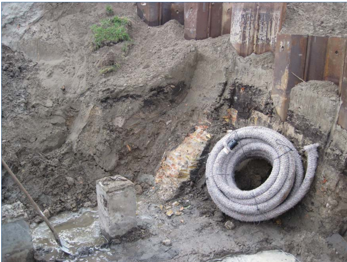
Figuur 4. Fundering van de westelijke muur met spoornummer 106.
