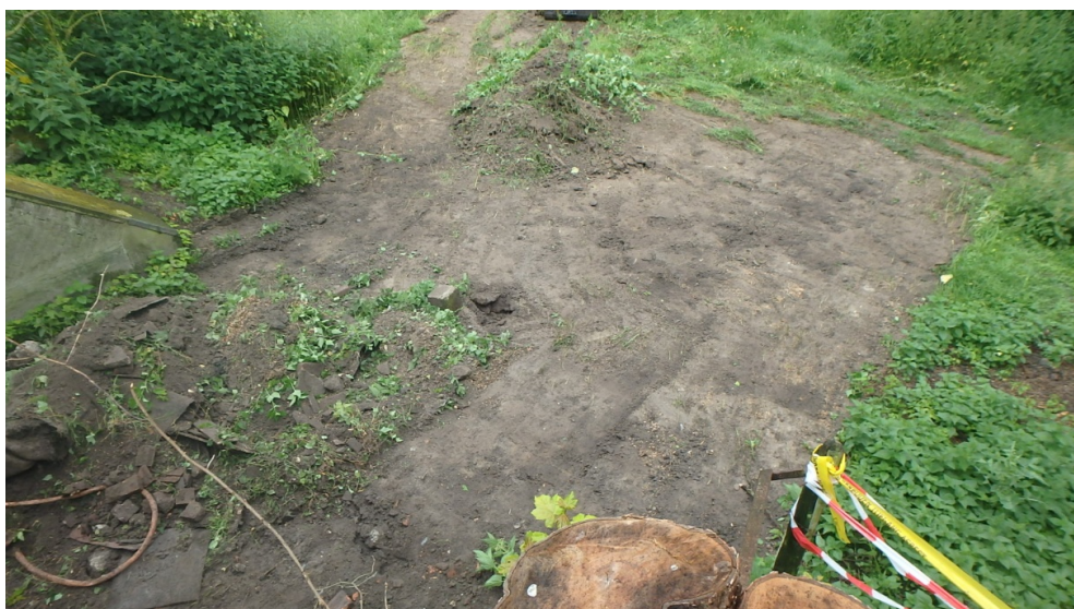
Afb. 12 Afgraving van de bovenste 5 cm gezien vanaf het fort.
