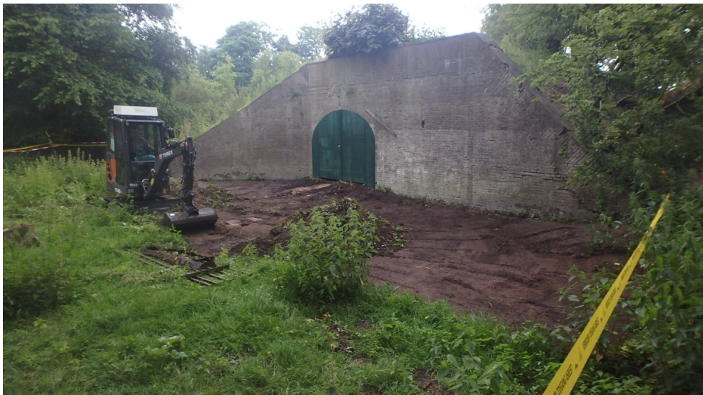
Afb. 11 Afgraving van de bovenste 5 cm door een minigraver.
