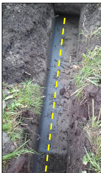
Afbeelding 2. De in de tekst genoemde sloot in het vlak van de kabelsleuf, links van de stippellijn
