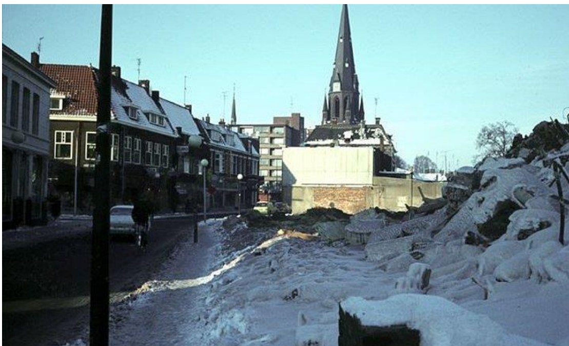
Afbeelding 14. De oude Oldenzaalsestraat (nu De Heurne) in 1977. De panden aan de rechterzijde van de straat worden gesloopt voor de aanleg van de nieuwe Oldenzaalsestraat
