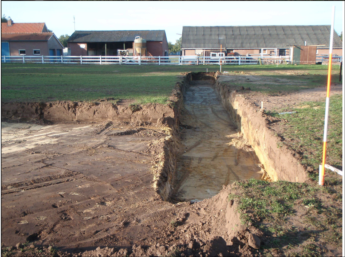
Figuur 3. De gaafwerkzaamheden in en rond het plangebied tijdens het veldwerk (9 oktober 2013).
