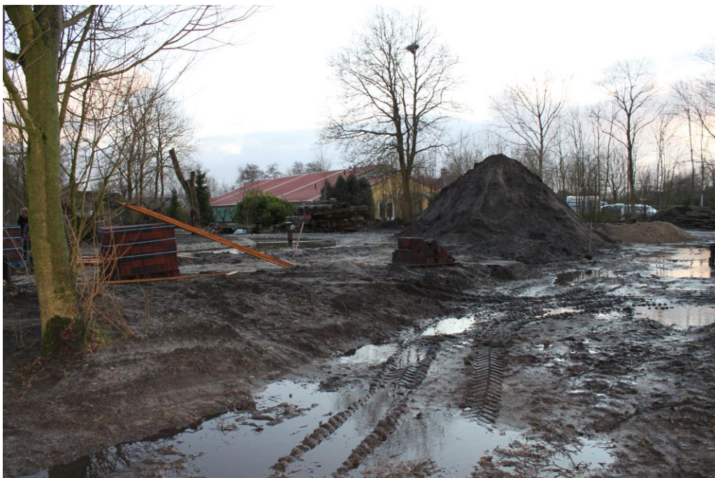
Figuur 6: Het plangebied gezien vanuit het noorden. Door de obstakels moest bij een aantal boringen worden afgeweken van de geplande boorlocaties.
