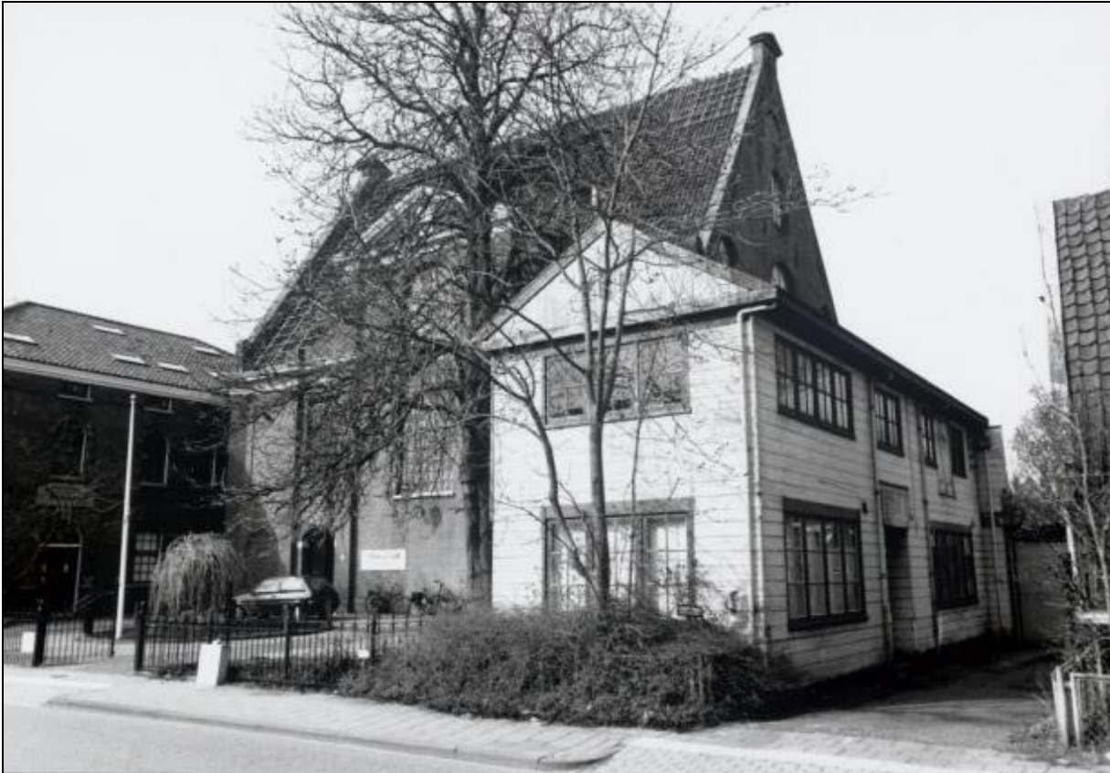
Figuur 4: Foto uit 2002 met hierop het voormalige houten gebouw Vinkenstraat 30 in het zuidoostelijke deel van het plangebied, gesloopt in circa 2004. Links naast dit gebouw is de Lutherse Kerk te zien (Bron: www.archief.zaandstad.nl ).
