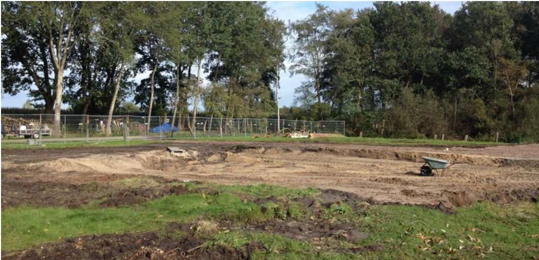
Figuur 5: Foto van na de recente sloop.
