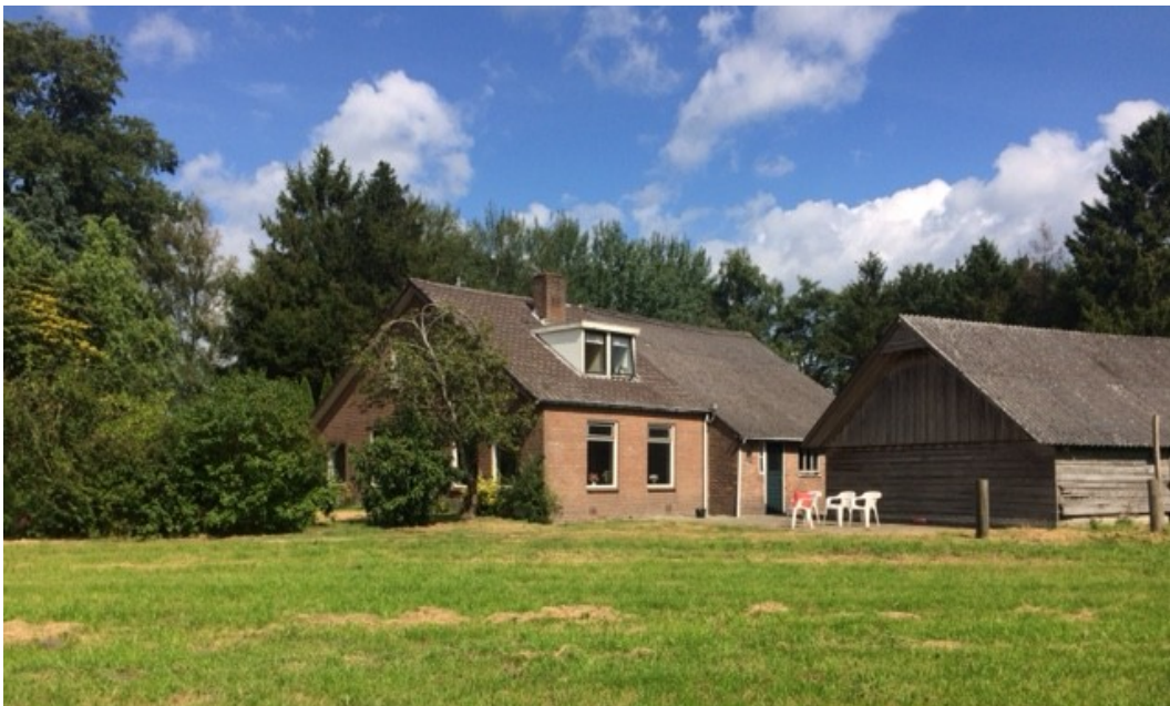
Figuur 4: Foto van de gesloopte bebouwing.
