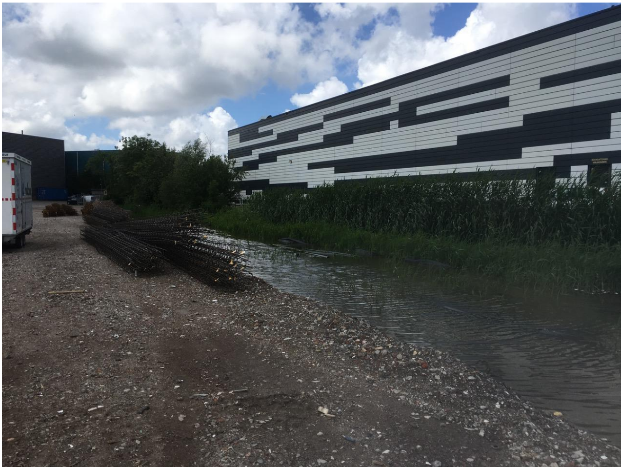
Afbeelding 5. Situatie circa begin juni 2017. Op het terrein is een laag puingranulaat aangebracht. Foto is gemaakt met zicht naar het westen.
