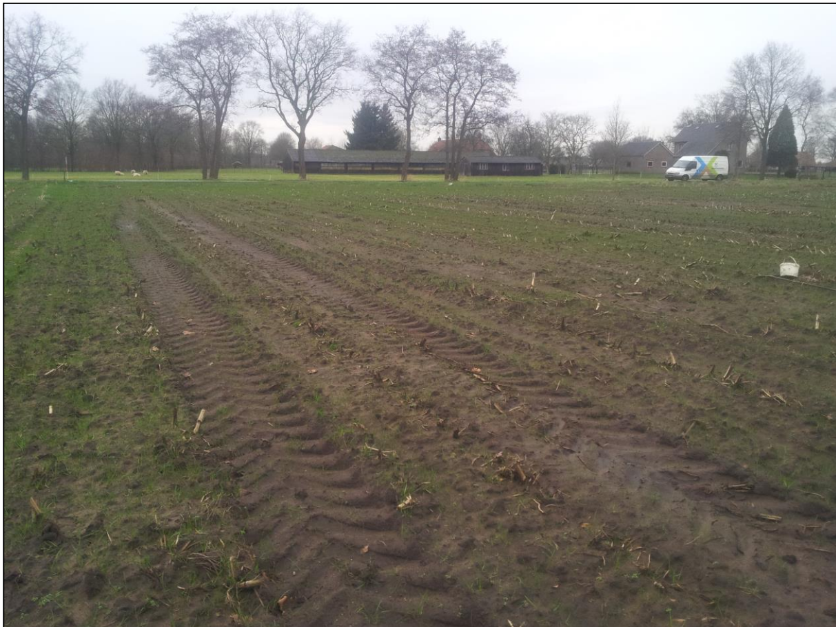
Figuur 2: Het plangebied bij aanvang van de werkzaamheden in noordwestelijke richting.
