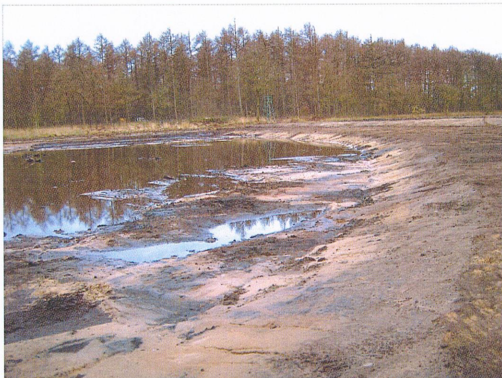
Afbeelding 11. Dobbe 3 vanuit het noordoosten gezien, na afloop van de graafwerkzaamheden.
