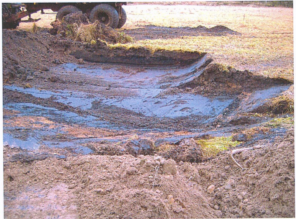
Afbeelding 8. Dobbe 3, start van graafwerkzaamheden vanaf de zuidoostelijke rand van de dobbe.
