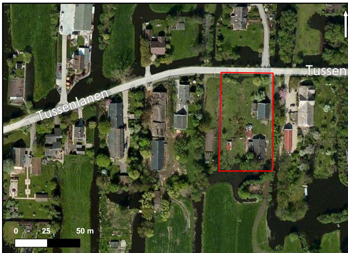
Figuur 1. Het plangebied (rood omlijnd) op een luchtfoto uit 2010 (bron: Bing Maps).
