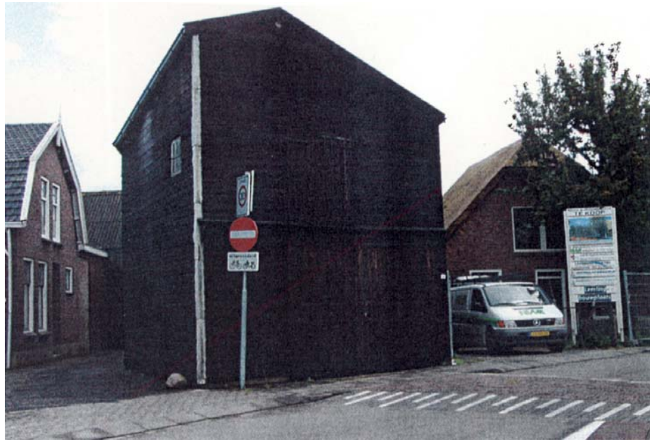
Afb. 8. De zuidgevel van de brandstoffenloods (Foto uit archeomedia verslag nr. 2).
