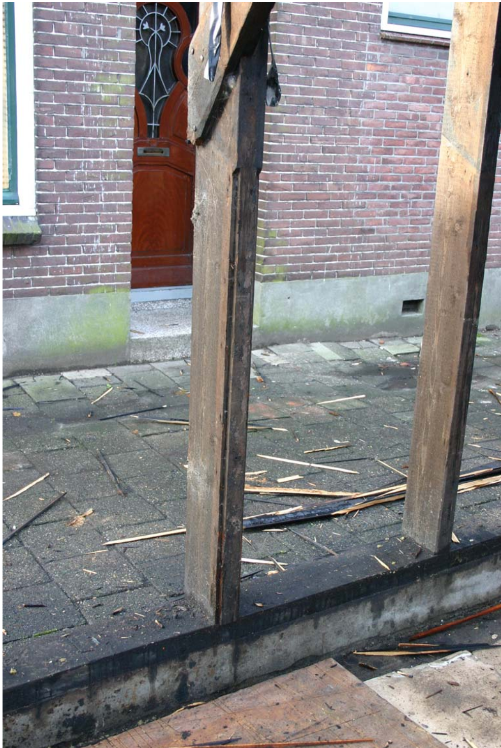
Afb. 12. Detail van een gebintstijl met sponning aan de westzijde van het gebouw.
