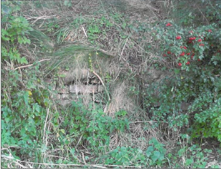
Afb. 15. Detail van bruggenhoofd (bron: Immerseel, 2007.)
