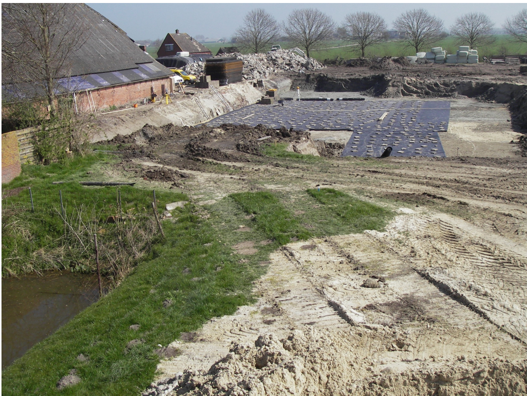
Figuur 5. Oldehove, Jensemaweg 15. Foto van het plangebied. De foto is gemaakt richting het oosten.
