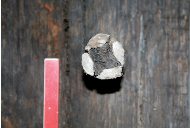
Afbeelding 14 Detailopname van een grenenhouten pen met eikenhouten deutel afkomstig van LSH 36.
