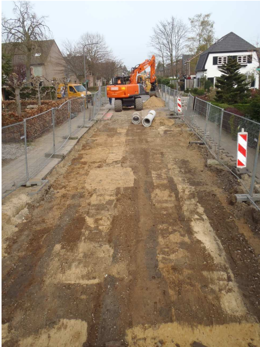
Figuur 2. Spankerenseweg na het verwijderen van de oppervlakteverharding. De oude rioolsleuf tekent zich al af als verstoring.
