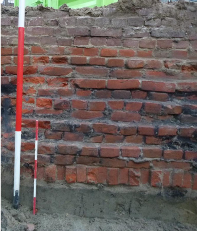
Figuur 1. Profielkolom opgenomen tijdens de ondergrondse sloop. De onderste rollaag van de muur ligt op een laag bouwzand die over de onderkant van de bouwvoor ligt.
